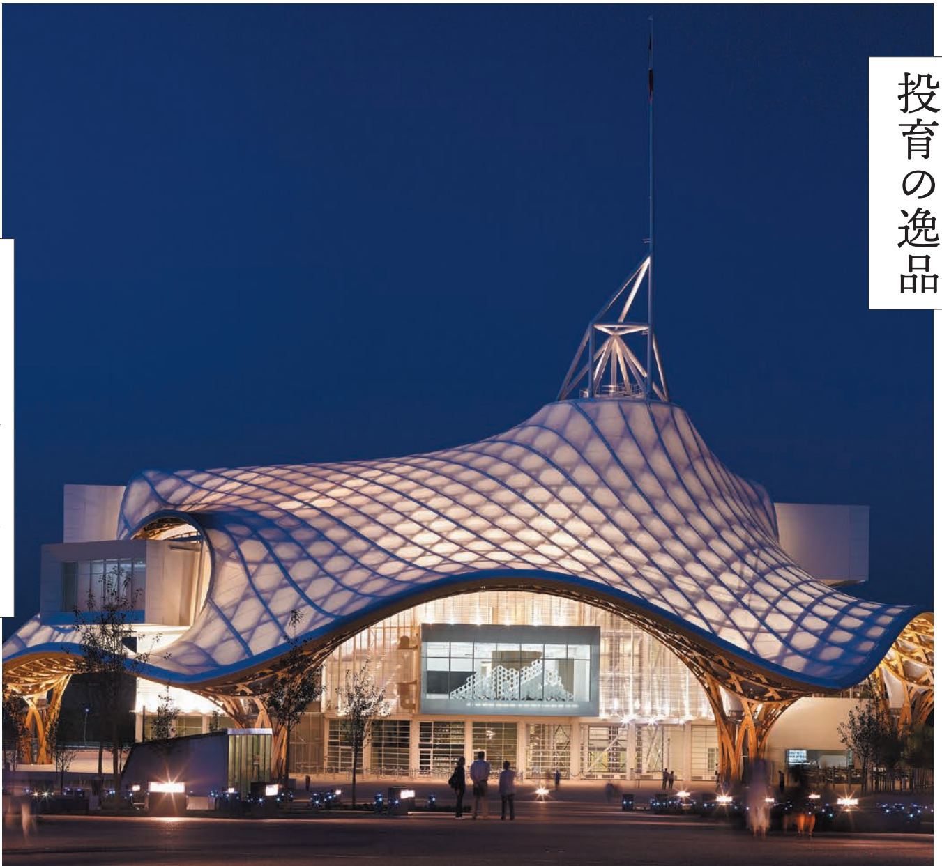
ポンピドゥー・センター・メツ（フランス）の屋根の膜材
